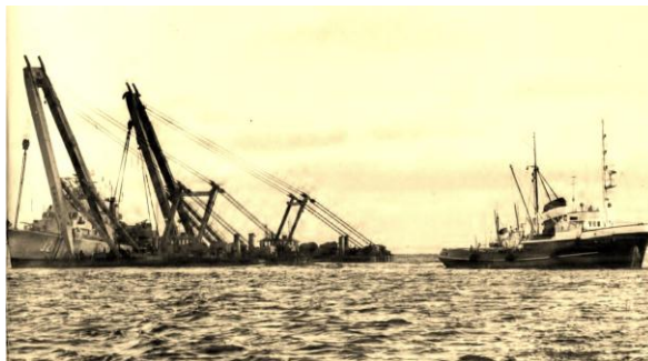
Lyftkranar på plats vid Södermanland
