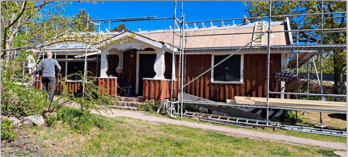
Byggställning och byggjobbare på plats, gamla tegelpannor borttagna.....
