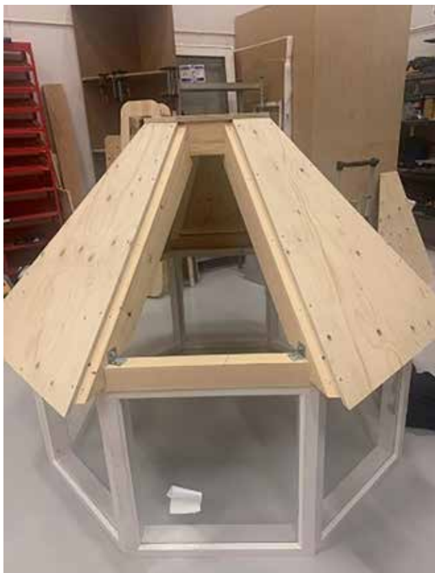
Lanterninen under byggnation hos Lindvalls Specialsnickerier.
